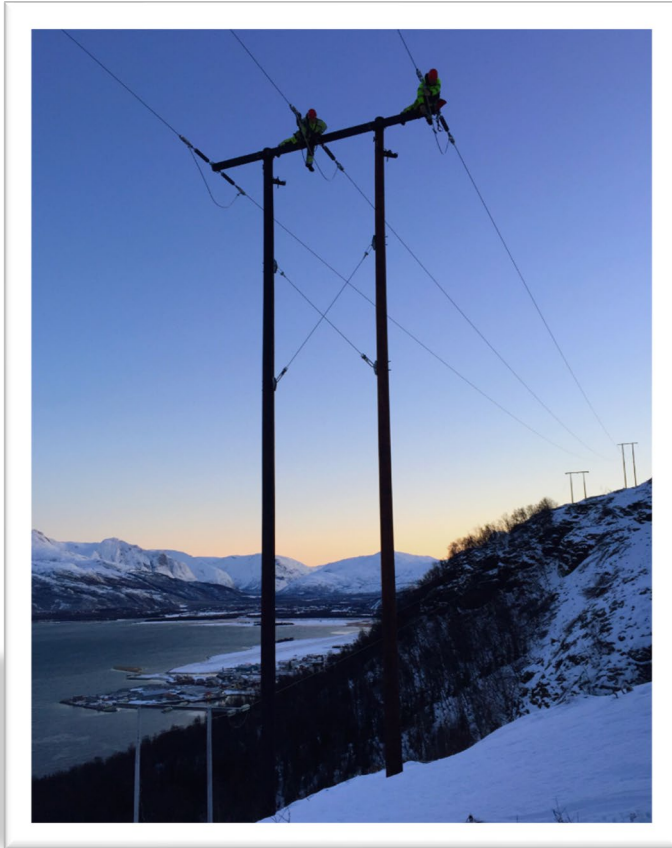
Montørene Jim og Harald befarer den nye 66 kV linjen fra Storslett til Hamneidet. Fotograf Ravmond Torbjørnsen
